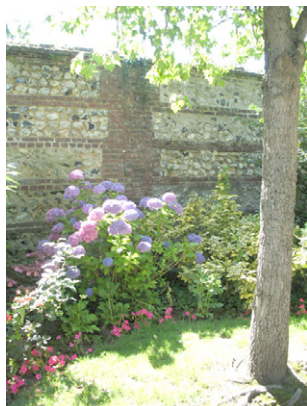
Mur sur l'emplacement des remparts dans le jardin Béthanie.
