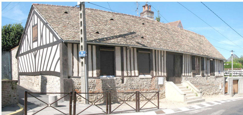
Maison à colombages rue Girardin.
