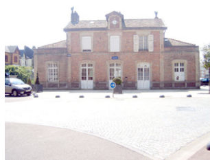
La gare a été placée dans l'axe de la rue R. Coty rappelant les gestes urbains des villes.
