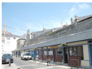
Les hallettes abritent les échoppes des commerçants le long du mur de l'Abbaye.
